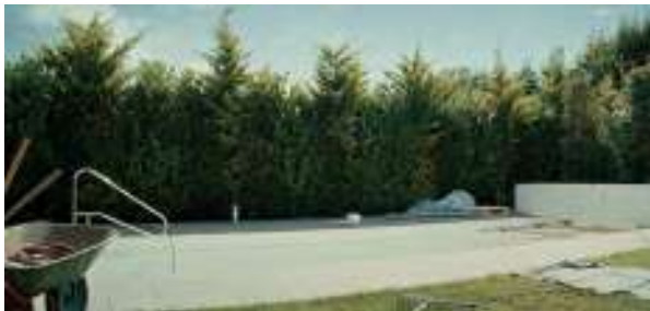
La finalisation de la construction de la piscine
